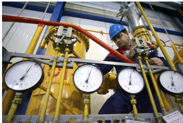
Рис. 6.3. Устранение аварии на системах газоснабжения
