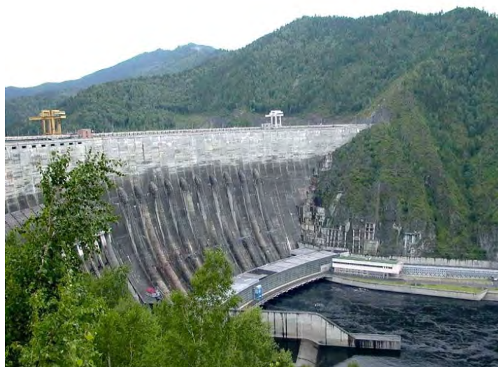
Рис. 4.1. Внешний вид плотины
