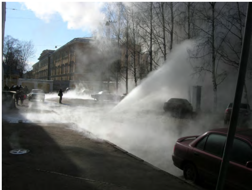
Рис. 6.6. Прорыв трубопровода на теплотрассе высокого давления
